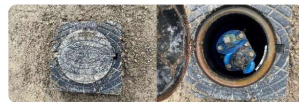
Die TELE-Straßenkappe ist aus dem Planum nach oben ziehen. Mit Asphalt und/oder Beton unterfüllen und einwalzen. Die Gummi-Dichtung des Edelstahl-Innendeckels ist beim Asphaltieren wegen hohen Temperaturen zu entfernen.
