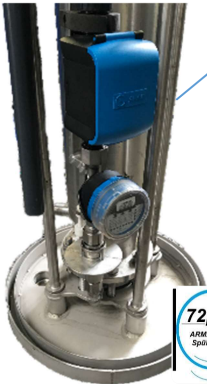
automatisches Spülsystem 72plus programmiert Leitungen nach DIN 1988 u. DVGW/VDI 6023spülen
