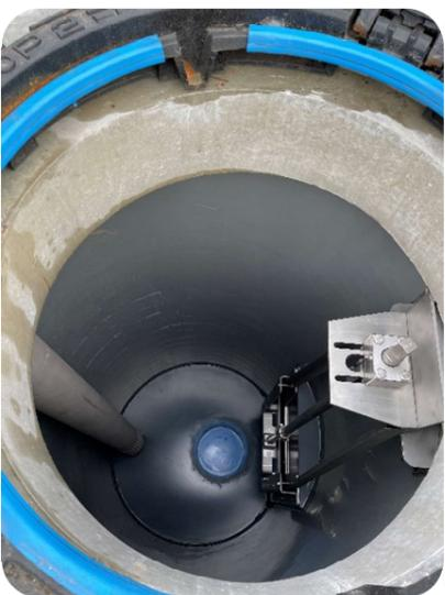
VARIO-FIX-BOX, DROSSELSCHACHT DN 1.000 – mit Elektroantrieb (vorbereitet)
