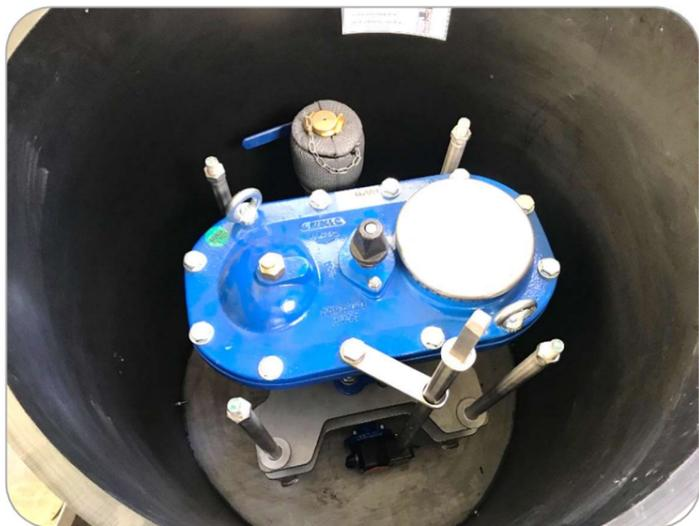
VARIO-FIX System mit FLEX SYSTEM BEV VENTEX DN 200
