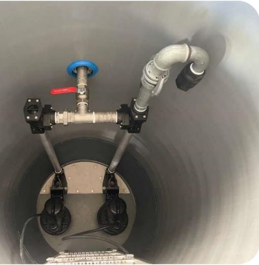
VARIO-FIX-PUMPENSCHACHT mit Doppelpumpanlage
