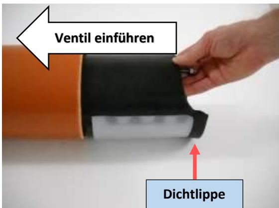
b) Das Ventil in das Rohr schieben bis die Dichtlippe ganz im Rohr aufliegt. Wenn korrekt eingefügt, sollte das Ventil in der Röhre sitzen wie in Bild c).
